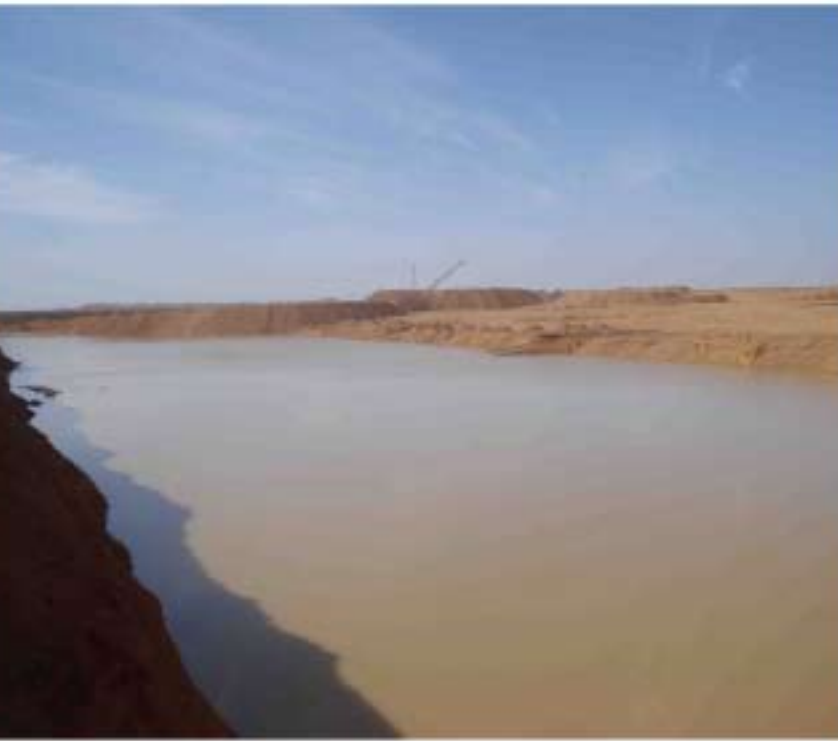
أحد مشاريع تجميع المياه
